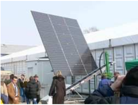
Panely s natáčením ve dvou osách - roční produkce cca 150 kWh/m 2 (136%)
