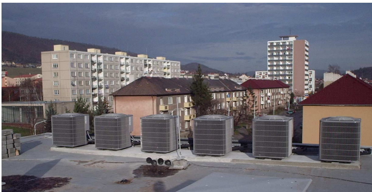
Pohled ze střechy panelového domu do okolí
